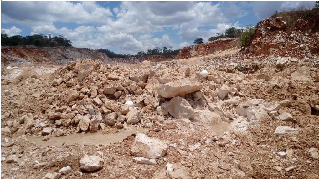
Figura 33. Resultado do desmonte (Desmonte III)
