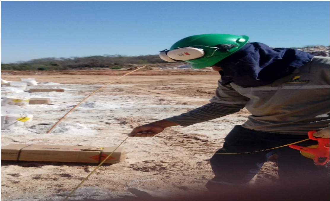
Figura 11. Medição da profundidade dos furos
